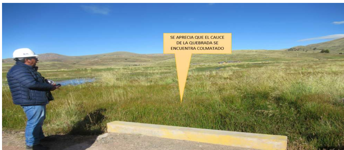
FIGURA N°02: SE APRECIA EL CAUCE DE LA QUEBRADA JATUN HUAICCO QUE REQUIERE DE LIMPIEZA YA QUE SE ENCUENTRA COLMATADO CON MALESAS Y DE LA MISMA FORMA REQUIERE DE CONFORMACION DE DIQUE EN AMBOS MARGENES.
