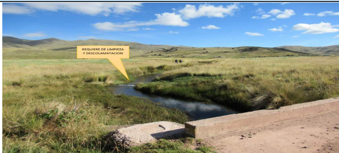
FIGURA 1 : SE APRECIA TRAMO DEL CAUCE QUE REQUIERE DE LIMPIEZA Y DESCOLMATACION DEL CAUCE DE LA QUEBRADA JATUN HUAICCO, DE LA COMUNIDAD SAN JOSE DE SANTA CRUZ Y TUPAC AMARU DEL DISTRITO DE PEDRO VILCA APAZA.
